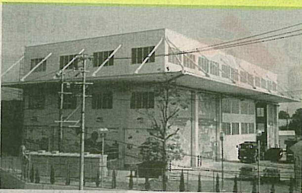
近く稼働する加山興業豊川工場の「RPF製造プラント」
