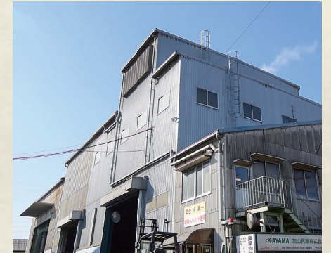
焼却プラント
