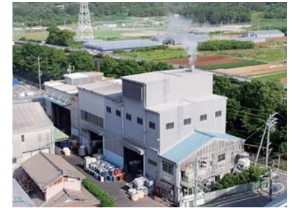
焼却プラント(クリーンな水蒸気が排出されている)
